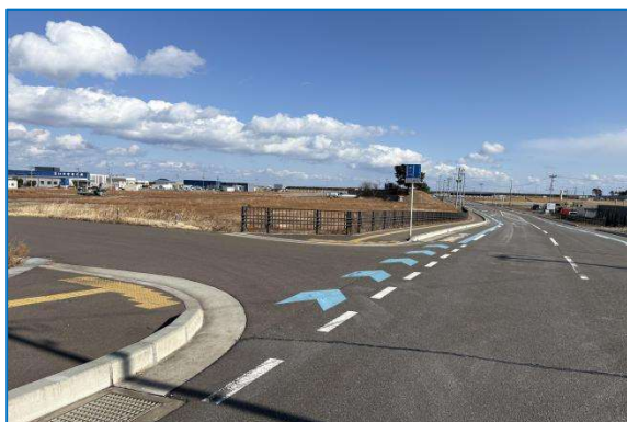
＜名取市関上地区 震災復興工事＞
