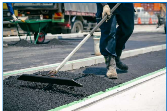
＜アスファルト舗装 施工写真＞
