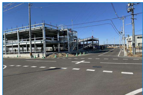
＜仙台市若林区六丁の目工業団地 震災復興工事＞
